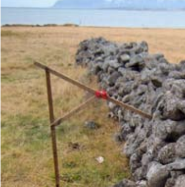
Efnismikill vörslugarður um Eyratúnið í Ólafsdal. Þar skorti ekki hráefni til garðhleðslunnar. Stíkan á myndinni mælir 1,0 m. (BG)
